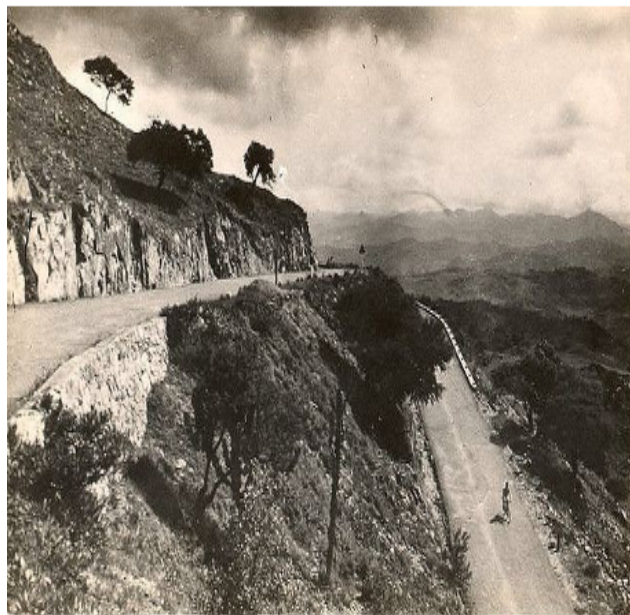
ΑΝΗΦΟΡΙΚΟΣ ΔΡΟΜΟΣ ΠΡΟΣ ΤΟ ΕΣΩΤΕΡΙΚΟ ΤΗΣ ΕΡΥΘΡΑΙΑΣ.
