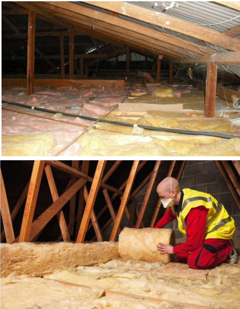
Εικόνα 7.5. Μόνωση οροφής με πετροβάμβακα.
