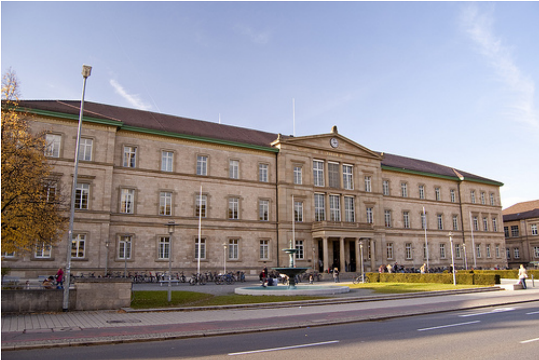
Εικόνα 4.1. Επιμηκές σχήμα κτηρίου το οποίο είναι το καλύτερο σχήμα για το κλίμα της Ελλάδος.
