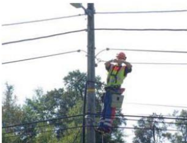
Εικόνα 3 - Εγκατάσταση οπτικής ίνας σε πυλώνα μεταφοράς ηλεκτρικής ισχύος
