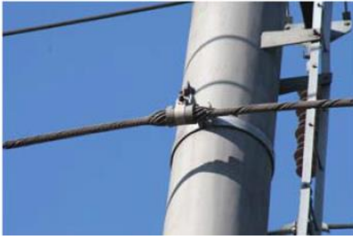
Εικόνα 4 - Ανάρτηση καλωδίου οπτικής ίνας
