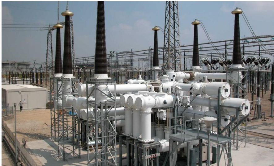
Εικόνα 2. Υποσταθμός με μόνωση αερίου (GIS, Gas Insulated Substation/ Switchgear) [6].
