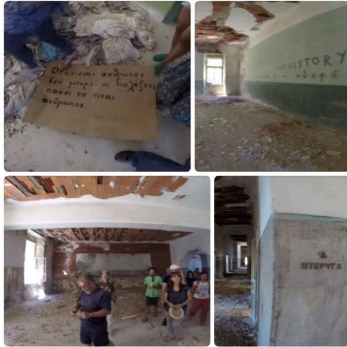
Εικόνα 41: Φωτογραφίες από το εσωτερικό του ψυχιατρείου. Στους τοίχους είναι αποτυπωμένες φράσεις από την περίοδο της φιλοξενίας των ανταρτοπαίδων. Πηγή: Ξενάγηση στα κτίρια του παλιού Ψυχιατρείου στα Λέπια Λέρου 20-06-2015 από τους ψυχιάτρους Γιάννη Λουκά και Θεόδωρο Μεγαλοοικονόμου, https://www.youtube.com/watch?v=W73Clp5Fbgl . Τα ρούχα της 1 ης εικόνας πάνω αριστερά είναι εγκαταλελειμμένα από πρόσφυγες. Στην εικόνα κάτω αριστερά, είναι ο χώρος όπου γινόταν θεατρικές παραστάσεις από τους πολιτικούς κρατούμενους.(Ανακτήθηκε 16/6/2023)
