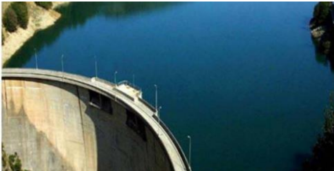
Εικόνα 13 Υπερχειλιστής στο κέντρο. Φράγμα Λίμνης Πλαστήρα
