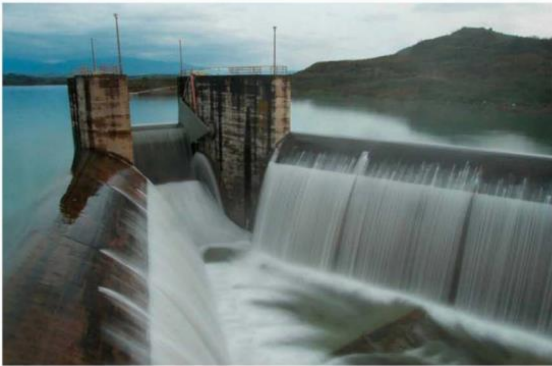
Εικόνα 12 Υπερχειλιστής φράγματος Πηνειού
