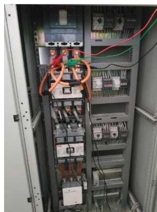
Εικόνα 11: Ερμάριο του διακόπτη λειτουργίας του Σπαστήρα 2- ΥΔ. 1 η Φάση Μετρήσεων
