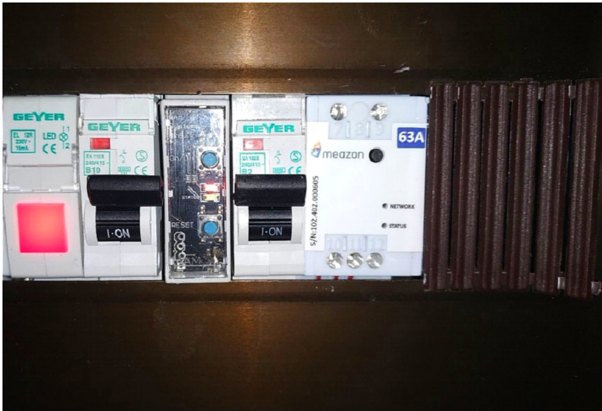
Σχήμα 2.14: Τριφασικός μετρητής "DinRail Advanced 3-Phase"
