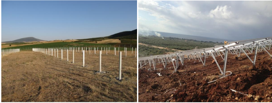
Εικόνα 2. Πασσαλόμπτυξη ράβδων στήριξης ΦΒ πάνελ [12].
