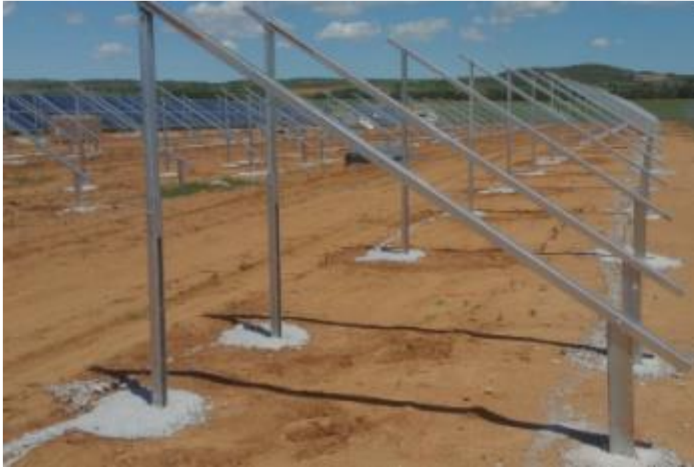
Εικόνα 4. Πάκτωση ράβδων στήριξης ΦΒ πάνελ σε μπετόν [13].
