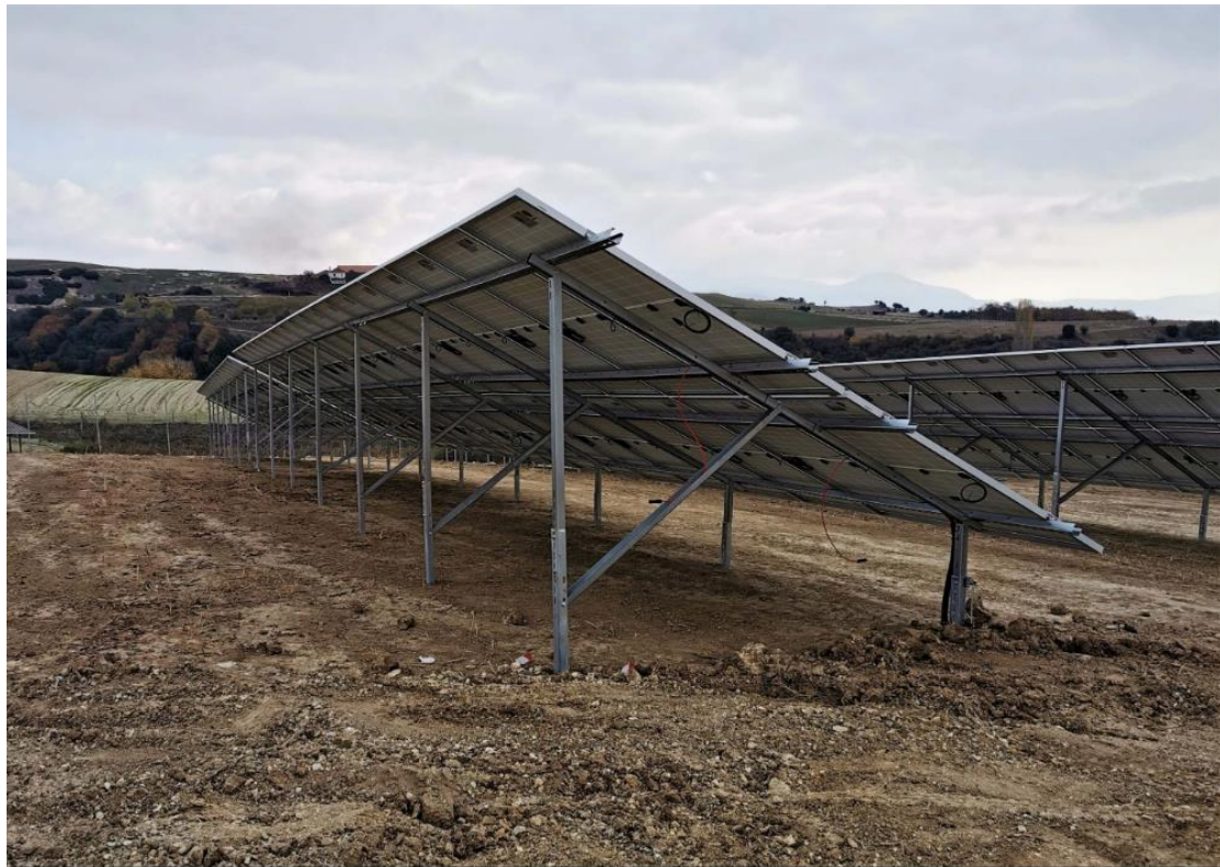
Εικόνα 3. Εγκατάσταση ΦΒ πάνελ με πασσαλόμπτυξη [11].
