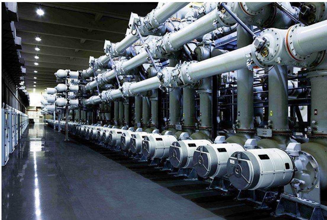
Εικόνα 2: Υποσταθμός GIS [2]
