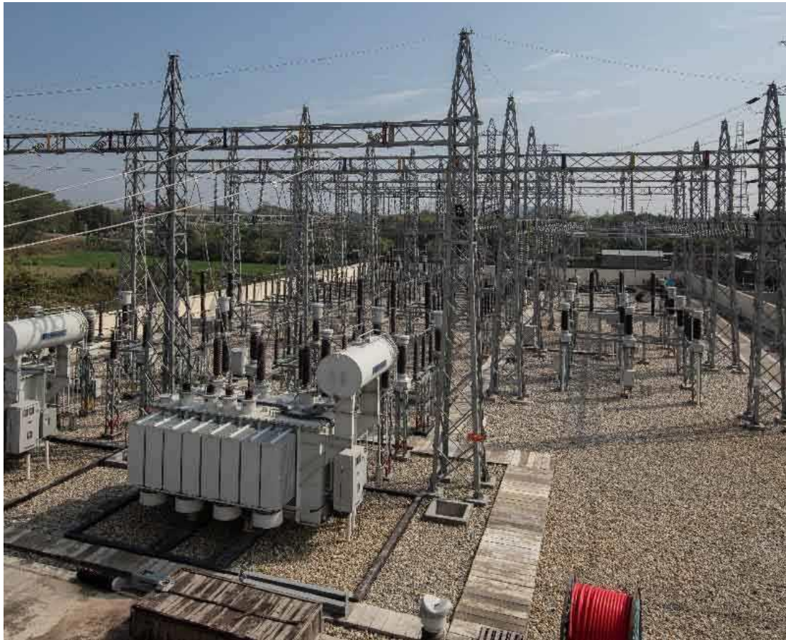
Εικόνα 1: Υποσταθμός AIS [1]
