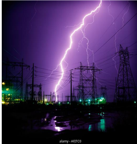
Εικόνα 15: Κεραυνικό πλήγμα σε υποσταθμό [11]
