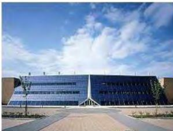
Σχήμα 4.8 Εφαρμογές φωτοβολταϊκών σε προσόψεις κτηρίων, πηγή: Σύνδεσμος Εταιριών Φωτοβολταϊκών
