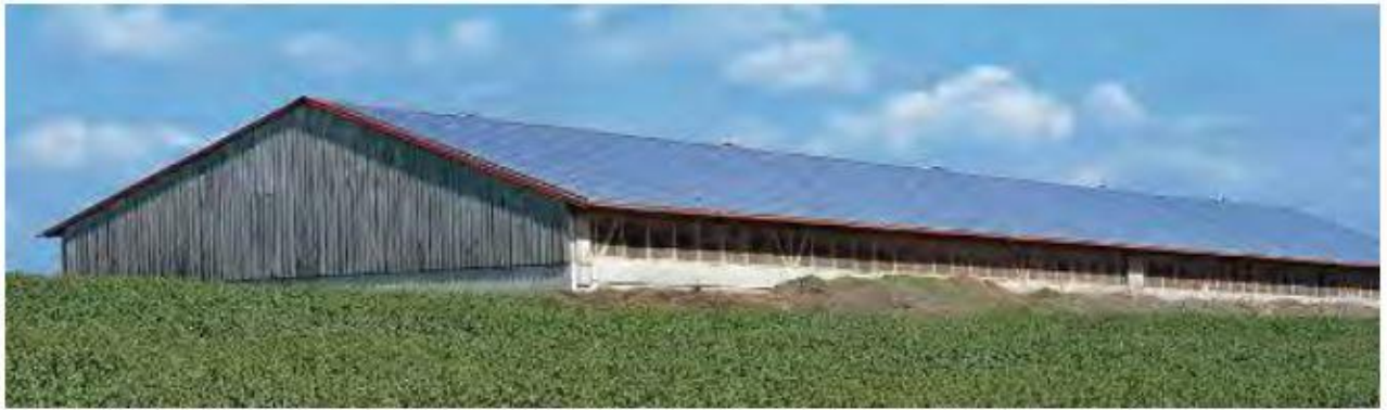
Σχήμα 4.5 Εφαρμογή φωτοβολταϊκών σε αγροτική αποθήκη, πηγή: Σύνδεσμος Εταιριών Φωτοβολταϊκών
