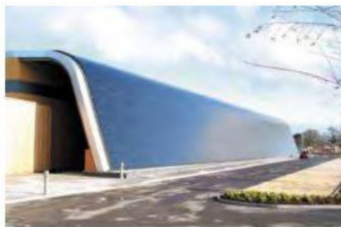
Σχήμα 4.6 Ενσωμάτωση φωτοβολταϊκών σε δημόσιο κτήριο, πηγή: Σύνδεσμος Εταιριών Φωτοβολταϊκών
