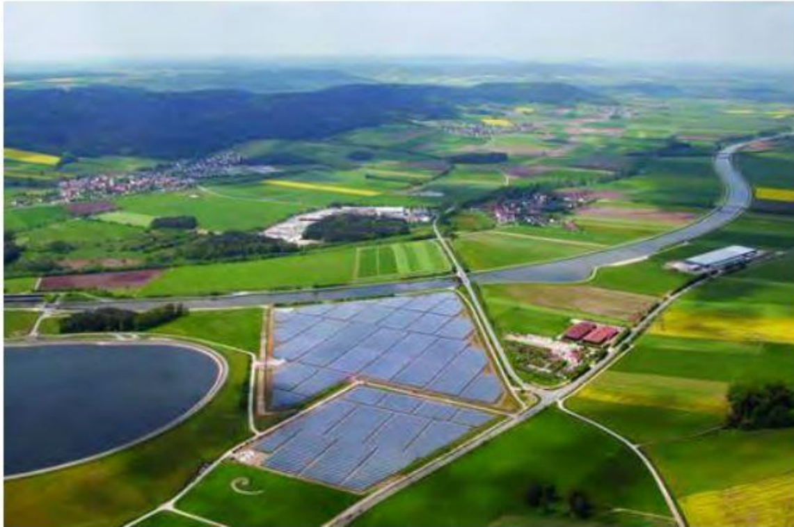
Σχήμα 4.10 Φωτοβολταϊκός σταθμός παραγωγής μεγάλης κλίμακας, πηγή: Σύνδεσμος Εταιριών Φωτοβολταϊκών
