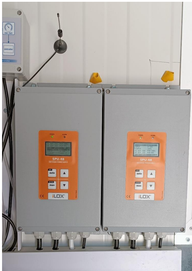
ΕΙΚ. 32-33: Ρυθμιστής φωτισμού, μετασχηματιστές για τον υποβιβασμό της τάσης
