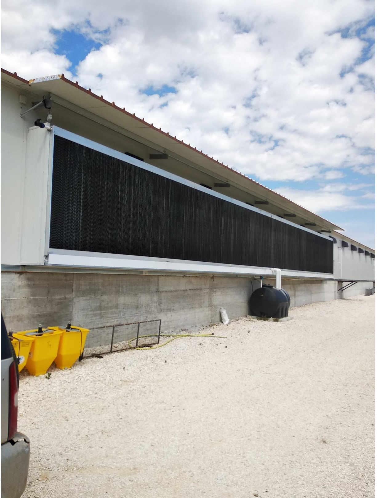
ΕΙΚ. 14: Υδροπάνελ για ψύξη κατά τις καλοκαιρινές κυρίως περιόδους
