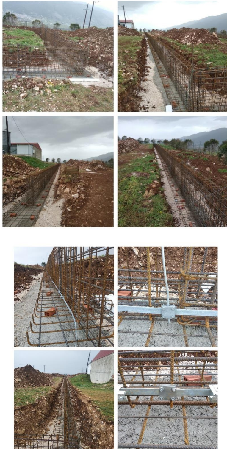
ΕΙΚ. 2: Θεμέλια του κτιρίου και θεμελιακή γείωση
