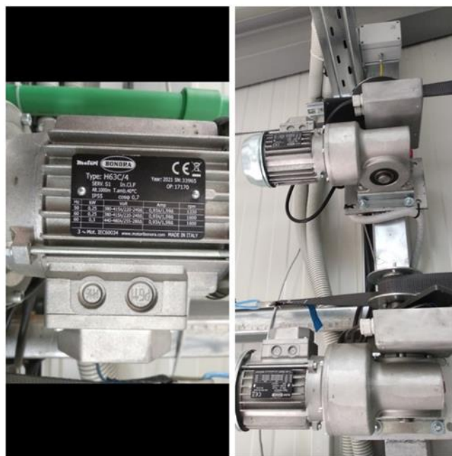
ΕΙΚ. 27: Μοτέρ παράθυρων για το άνοιγμα και για το κλείσιμο
