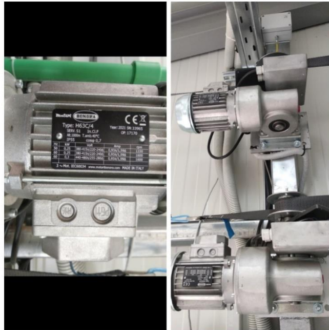
ΕΙΚ. 19: Μοτέρ παραθύρων για το άνοιγμα και το κλείσιμο
