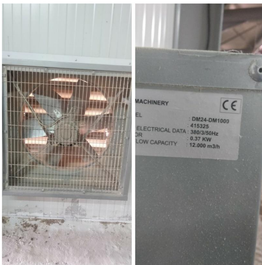
ΕΙΚ. 12: Ανεμιστήρας DM24
