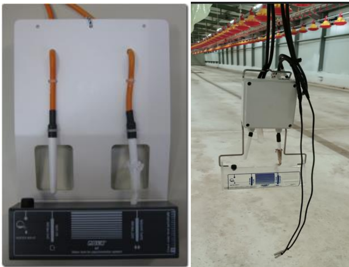
ΕΙΚ. 29: • Υγρασιόμετρο – Αισθητήριο θερμοκρασίας για την ένδειξη της θερμοκρασίας και της υγρασίας μέσα στο θάλαμο
