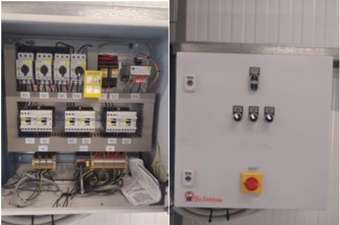
ΕΙΚ. 50-51: Πίνακας για την κίνηση των αλυσίδων ταΐσματος
