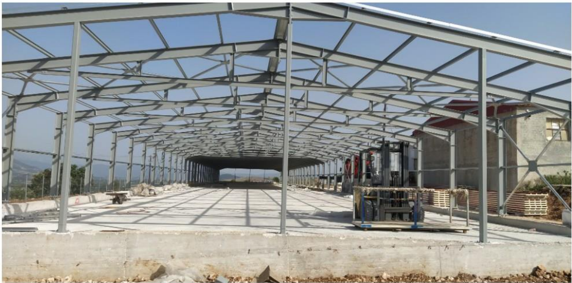
ΕΙΚ. 4: Στην εικόνα διαφαίνεται το στάδιο όπου γίνεται το κλείσιμο του κτιρίου
