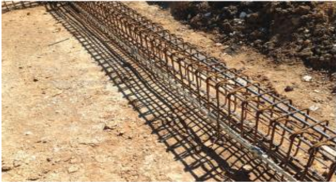
Εικόνα 22. Ορθή εγκατάσταση ταινίας 30 mm (X) 3,5 mm St-Zn για την δημιουργία θεμελιακής γείωσης επί του οπλισμού σε θεμέλια κτιρίου (Πηγή: ΕΛΟΤ, 2010)
