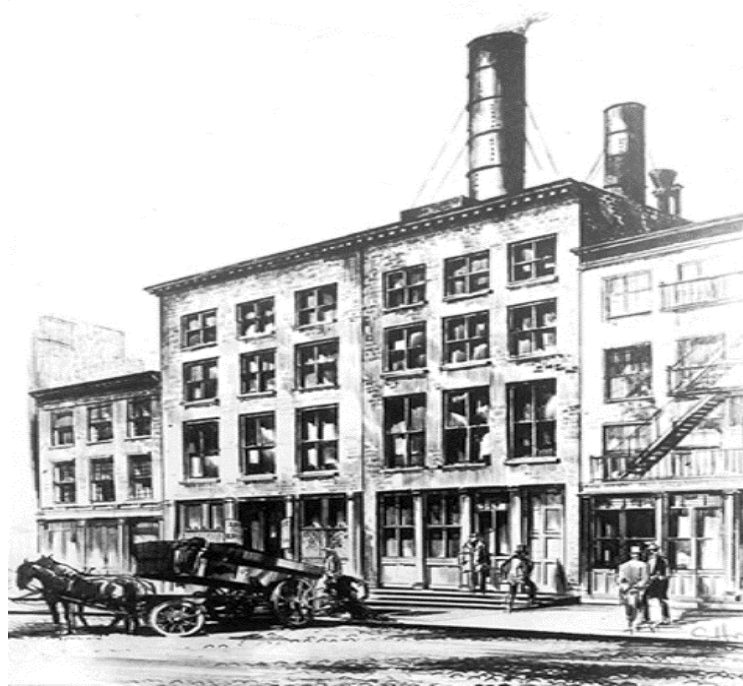
Εικόνα 10. Εγκατάσταση γείωσης σε κτίρια της οδού Pearl 257 στο Μανχάταν την χρονολογία 1882 (Πηγή: Edison, 2010)
