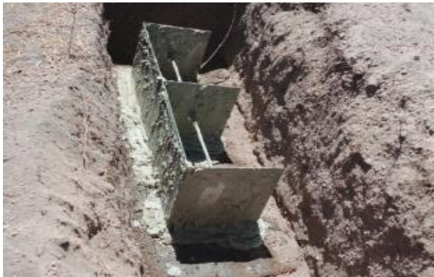
Εικόνα 26. Εγκατάσταση γειωτή τύπου E, για την ενίσχυση του συστήματος γείωσης του κτιρίου (Πηγή: ΕΛΟΤ, 2010)
