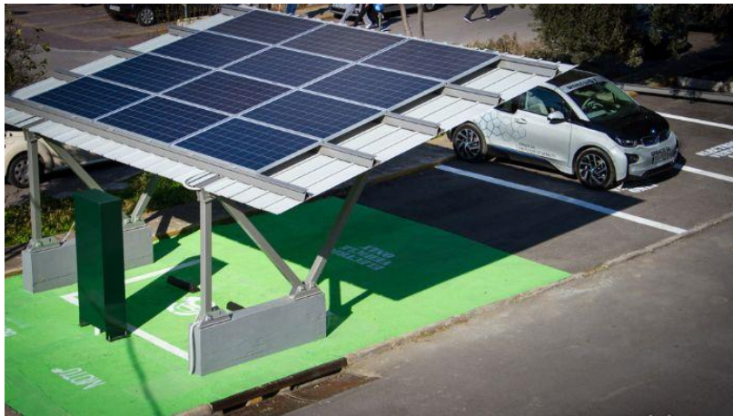
Εικόνα 27: Εγκατάσταση φωτοβολταϊκού σε σημείο φόρτισης
