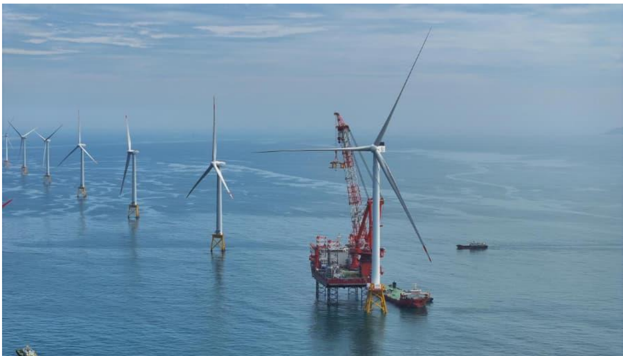
Εικόνα 23: Εγκατάσταση της μεγαλύτερης ανεμογεννήτριας στον κόσμο [23].
