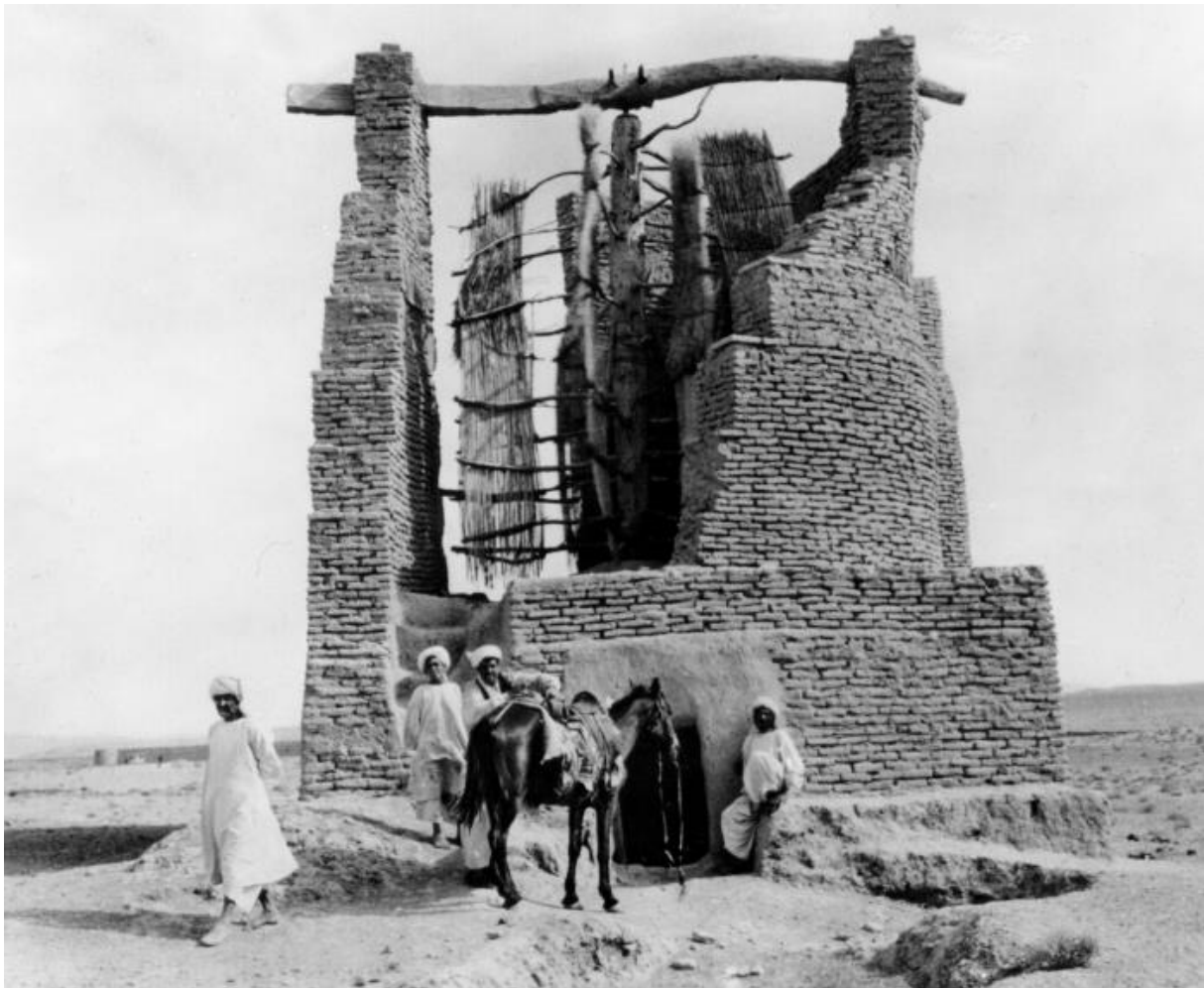
Εικόνα 15: Ανεμογεννήτρια κάθετου άξονα για άλεση σιτηρών, Αφγανιστάν [17].
