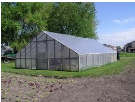
Εικόνα 2: ΑΜΦΙΡΡΙΚΤΟ ΑΠΛΟ ΘΕΡΜΟΚΗΠΙΟ
