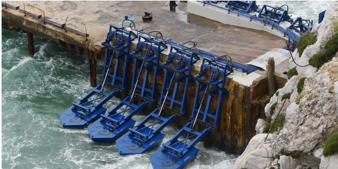
Εικόνα 2.11: Eco Wave Power συστοιχία εκμετάλλευσης κυματικής ενέργειας(05:)
