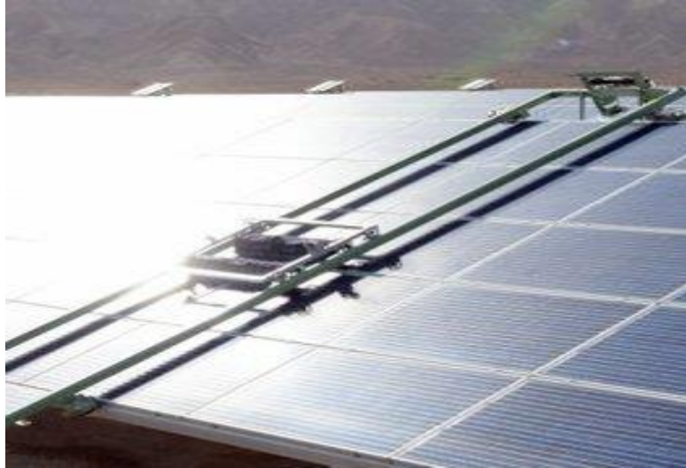
Εικόνα 44. Μηχανικός καθαρισμός των επιφανειών φωτοβολταϊκών πάνελς με χρήση ρομπότ (Πηγή: Grando et al 2017 31 )
