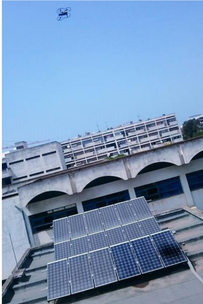
Εικόνα 52. Εναέρια θερμογράφηση φωτοβολταϊκών με χρήση drones (Πηγή: Zefri et al 2018 47 )
