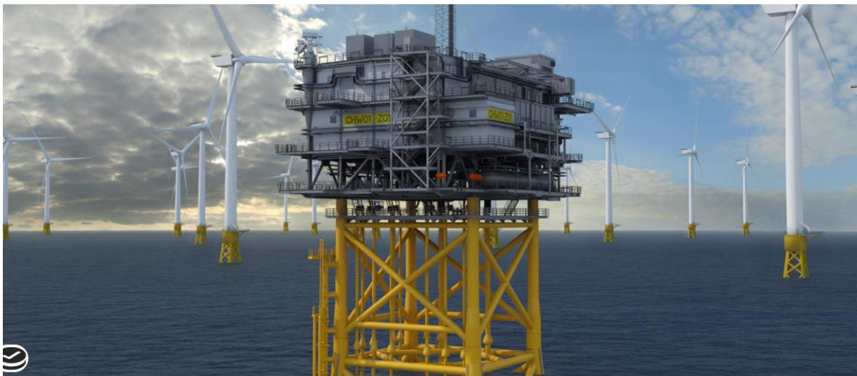
Εικόνα 18: Θαλάσσιος Υποσταθμός (Πηγή : ramboll.com/transformer-platforms )
