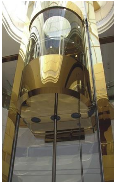
Εικόνα 6: Υδραυλικός ανελκυστήρας.
