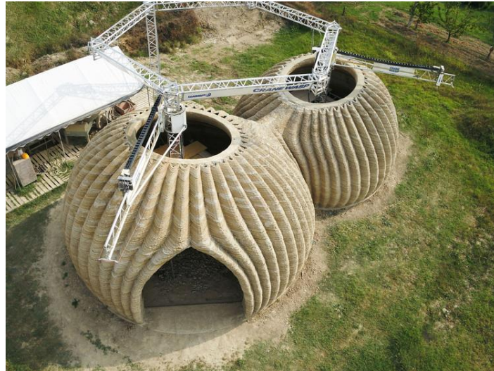
Εικόνα 6: 3D Construction (πηγή: https://www.constructionspecifier.com/germanys-first-3d-printed-building-is-now-under-construction/ )
