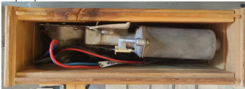
Εικόνα 77 Φωτογραφία από την τοποθέτηση των κινητήρων εντός των δύο κτισμάτων.
