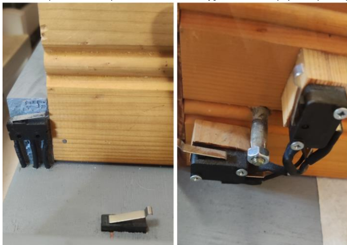
Εικόνα 76 Φωτογραφία από την τοποθέτηση και των τερματικών διακοπών.
