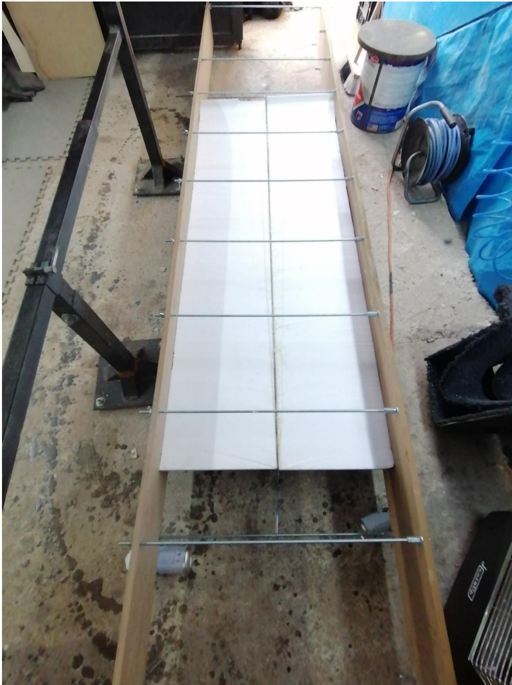
Εικόνα 28 διαδικασία πρέσας για την συγκόλληση της κεντρικής δοκού.
