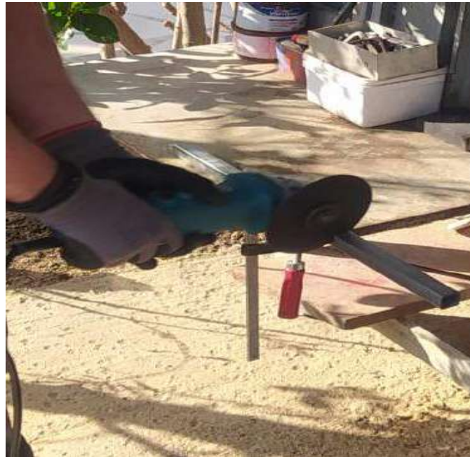
Φωτογραφία 1: Μέτρηση και κοπή των τεμαχίων
