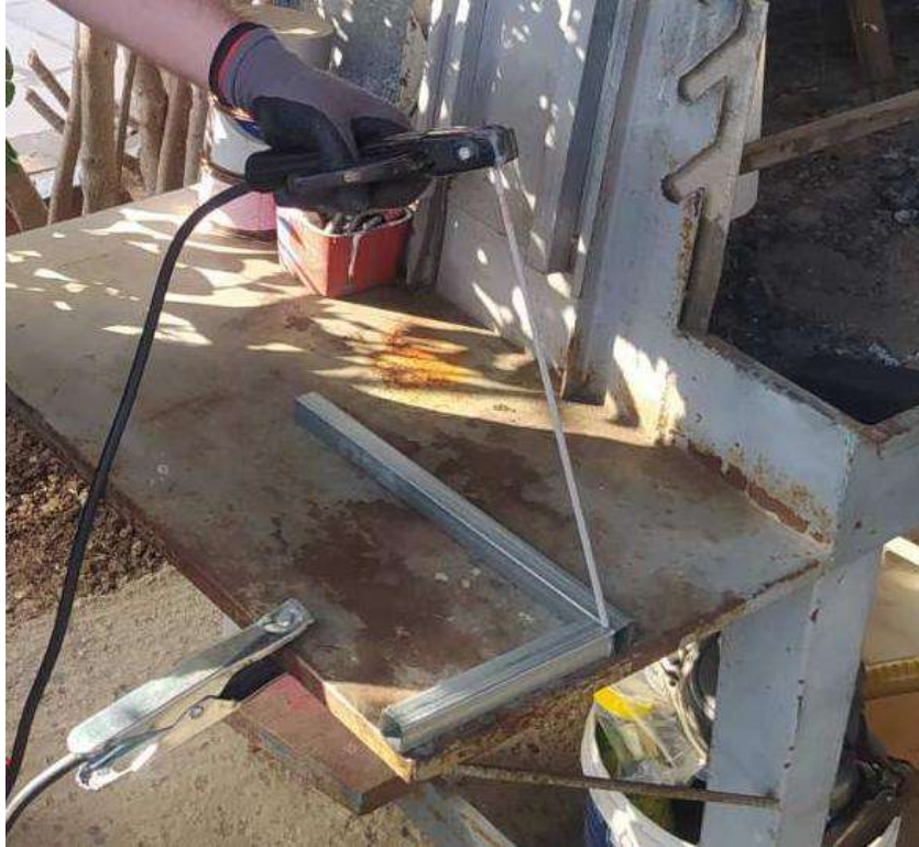
Φωτογραφία 9: Συγκόλληση τεμαχίων για την κατασκευή της βάσης της μέγγενης
