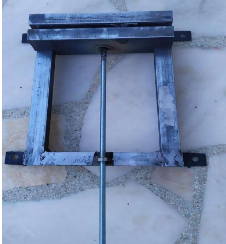
Φωτογραφία 11: Συγκόλληση ελασμάτων για την κατασκευή του κινητού σιαγόνα και τοποθέτηση ντίζας για την κίνηση της σιαγόνας προς τα μέσα ή προς τα έξω
