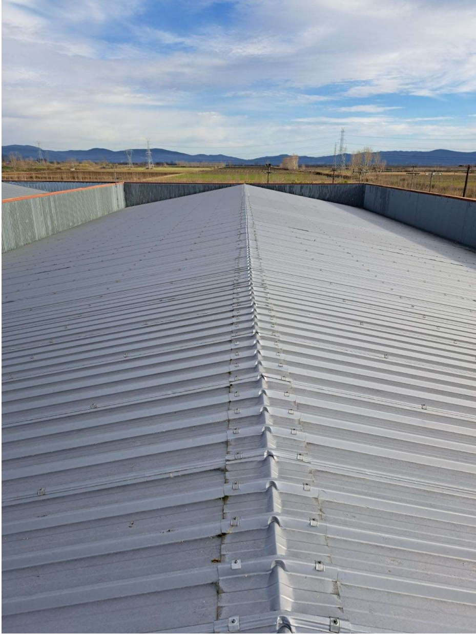
Εικόνα 12. Αποτύπωση στέγης βιομηχανίας
