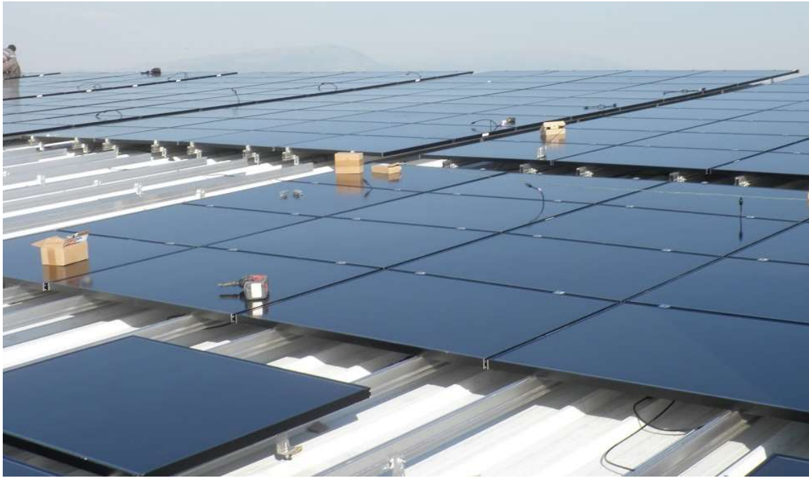
Εικόνα 21. Τοποθέτηση πλαισίων επί βάσεων βιομηχανικής στέγης ( ΠΗΓΗ Α.ΤΣΟΠΡΙΑΔΗΣ Γ. ΕΛΕΥΘΕΡΑΚΟΣ Ο.Ε.
