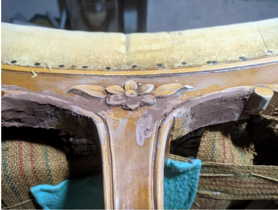
Εικόνα 19. Στοκάρισμα τραυματισμένου ποδιού
