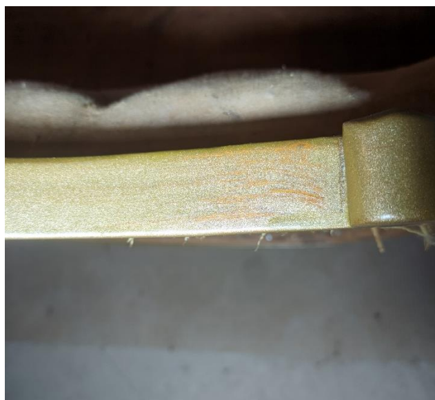
Εικόνα 25. Πρώτη επίστρωση μπογιάς
