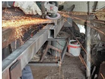
Εικόνα 207. Καθαρισμός με τροχό
