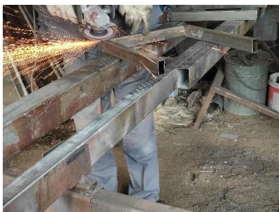
Εικόνα 201. Καθαρισμός περισσίου μετάλλου με τροχό
