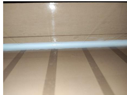
Εικόνα 85. Αφαίρεση περίσσειας σιλικόνης
