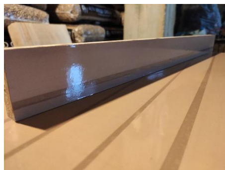
Εικόνα 79. Εφαρμογή κολλητικής ταινίας στην εσωτερική πλευρά
