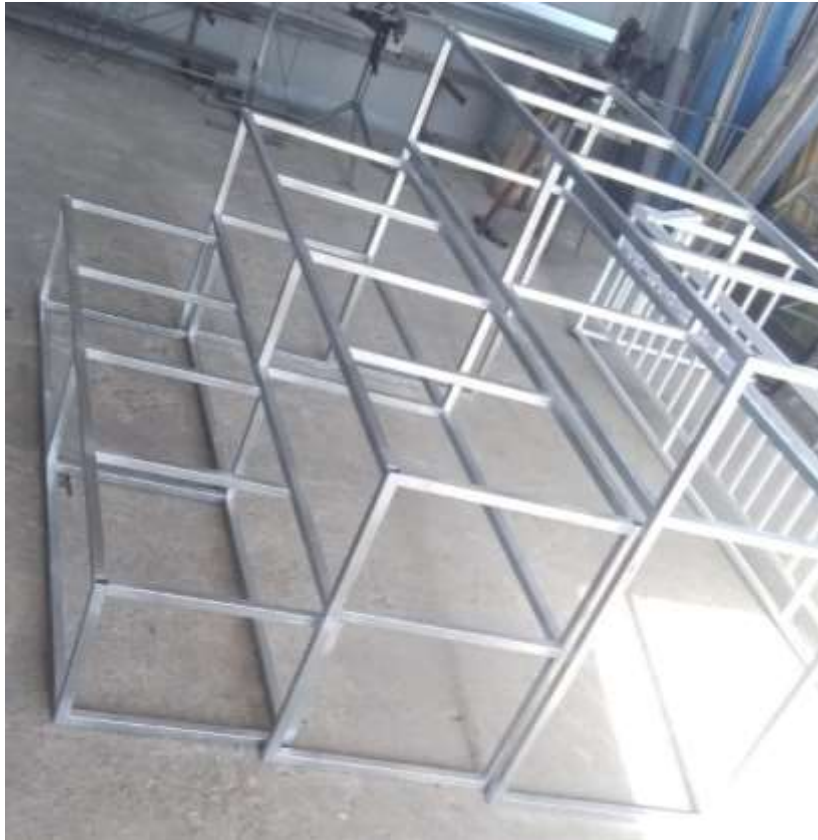
ΕΙΚΟΝΑ 12. Ολοκλήρωση μεταλλικής κατασκευής ανοιχτή.
