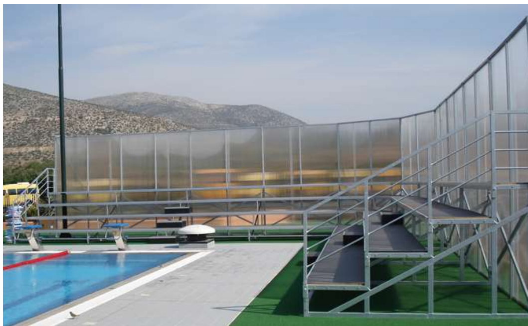
ΕΙΚΟΝΑ 2.2.3. Στη παραπάνω εικόνα βλέπουμε μια κερκίδα γωνιακού τύπου σε επίπεδα.
