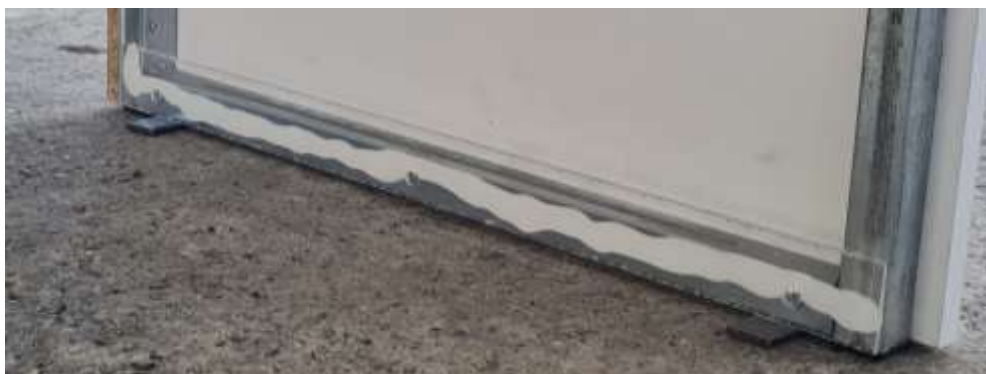
ΕΙΚΟΝΑ 15. Τοποθέτηση plexiglass για να λειτουργεί ως γλυσιέρα για να κουμπώνει το ένα πλαίσιο μέσα στο άλλο.
