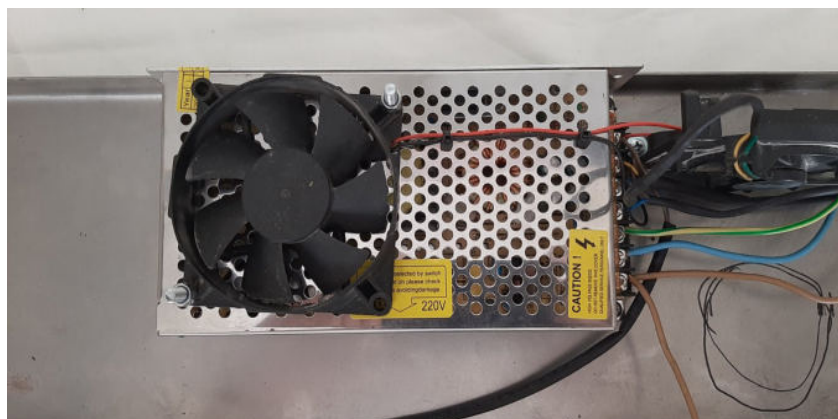
Εικόνα 86 : Τοποθέτηση και συνδεσμολογία ηλεκτρικού ανεμιστήρα 12 V για την ψήξη του τροφοδοτικού.
