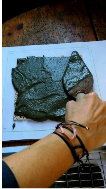
Εικ. 7.7.1.8: Τοποθέτηση κονιάματος με μυστρί με παλμικές κινήσεις
