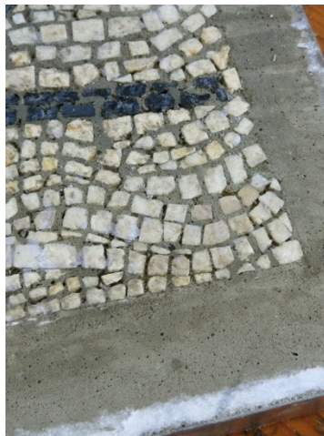
Εικ. 7.8.1.9: Επανατοποθέτηση ψηφίδας
