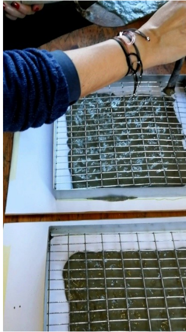
Εικ. 7.7.1.10: Τοποθέτηση τελάρου
