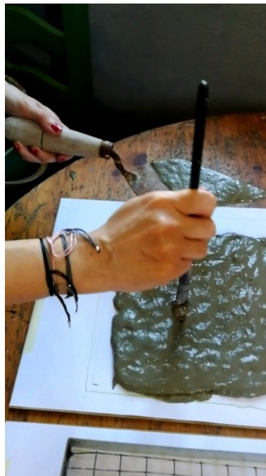
Εικ. 7.7.1.9: Τοποθέτηση κονιάματος με πινέλο
