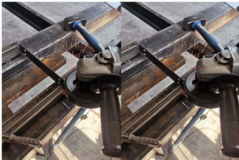
Εικόνα 4. 2 κοπή με τροχό των μεταλλικών βεργών
