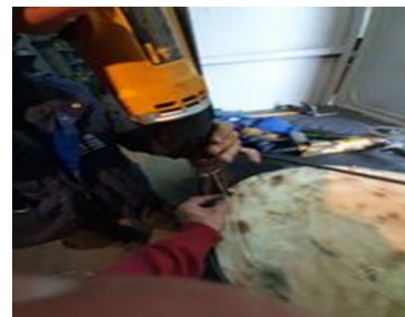
(Ανοιγμα οπής για την τοποθέτηση βίδας)
