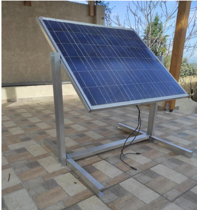
Εικόνα 4.4.10 Τελική μορφή κατασκευής 2
