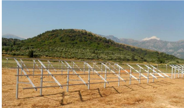
Εικόνα 1.5.1 Βάση σταθερού συστήματος στο έδαφος
