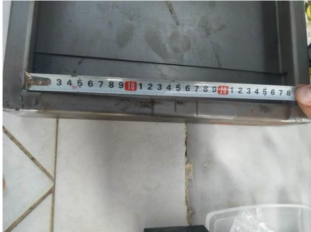
Εικόνα 63: Μέτρηση για να τοποθετηθεί το κολωνάκι
