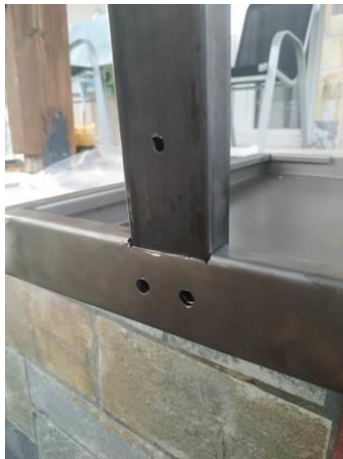
Εικόνα 69: Οι τρύπες για τα κολωνάκια στήριξης
