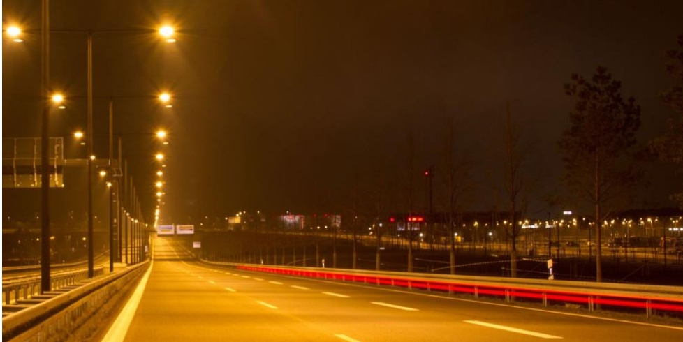
Εικόνα 51: HPS λάμπες σε αυτοκινητόδρομο
