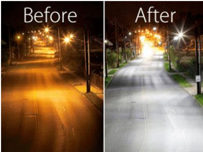
Εικόνα 53: Φωτισμός δρόμου με HPS και μετά την αντικατάσταση με LED λυχνίες
