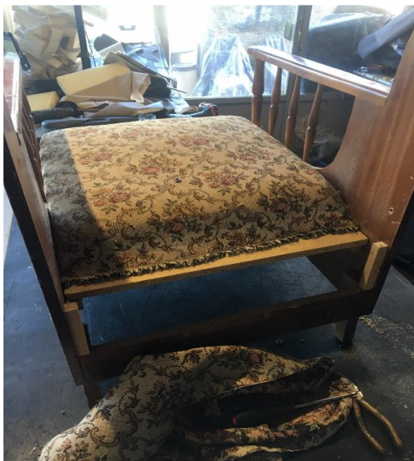
Εικόνα 10. Αφαίρεση πλάτης της καρέκλας.
