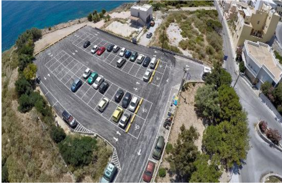
Εικόνα 337: Χώρος στάθμευσης Δόξα
