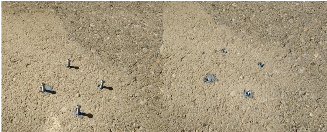
Εικόνα 81: Τελική εγκατάσταση αγκίστρων (βήμα 7)
