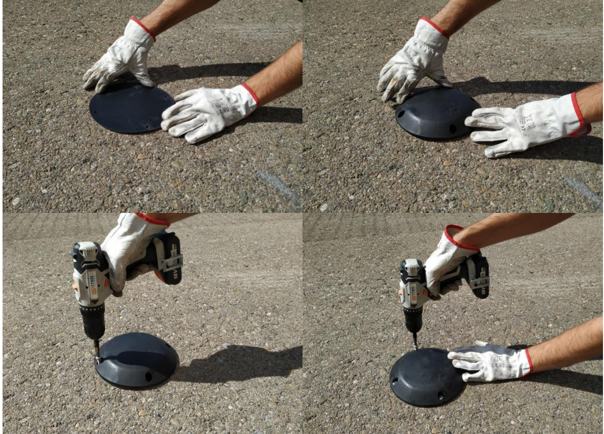
Εικόνα 82: Τοποθέτηση και βίδωμα του κόμβου
