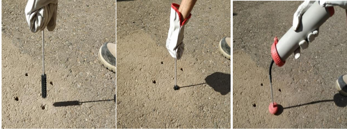
Εικόνα 78: Βούρτσισμα και φύσημα της οπής (βήματα 2,3 και 4)
