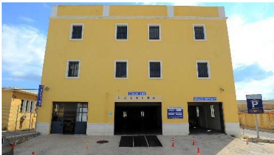
Εικόνα 315: Χώρος στάθμευσης Ι.Κ.Α.
