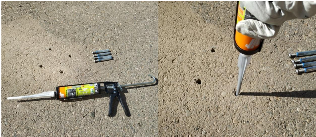
Εικόνα 79: Τοποθέτηση της χημικής στερέωσης (κόλλας) (βήμα 5)
