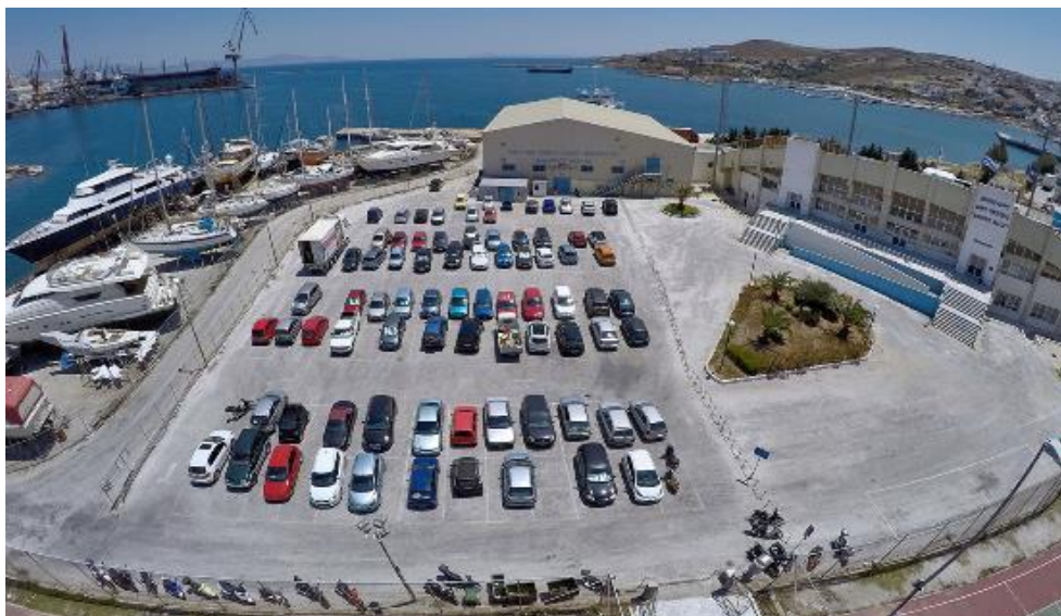
Εικόνα 41: Χώρος Στάθμευσης Αθλητικό κέντρο
