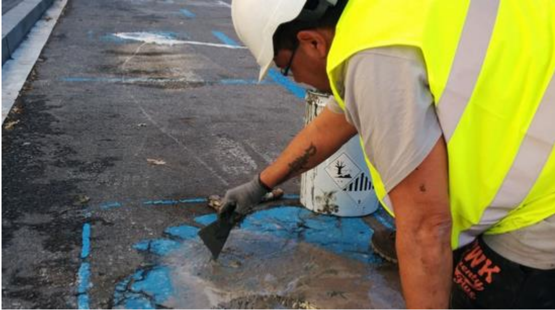
Εικόνα 164: Τοποθέτηση αισθητήρα σε θέση στάθμευσης
