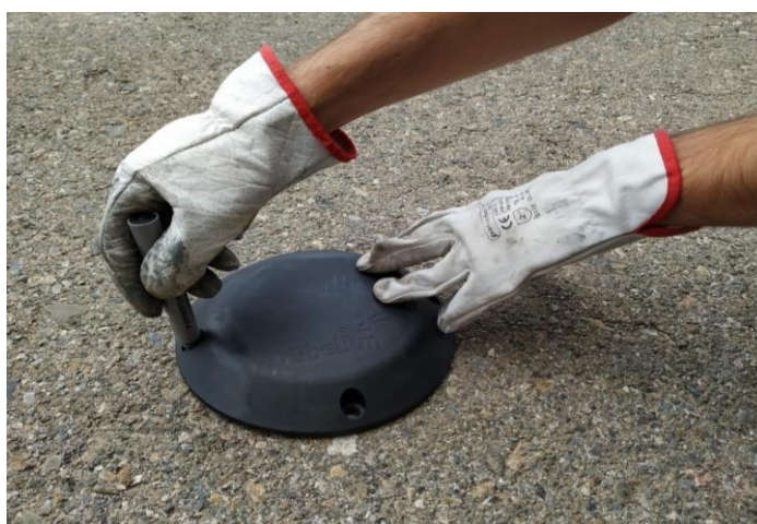
Εικόνα 75: Σήμανση των οπών για τον κόμβο
