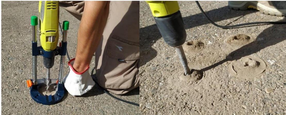
Σχήμα 77: Άνοιγμα οπών (βήμα 1)
