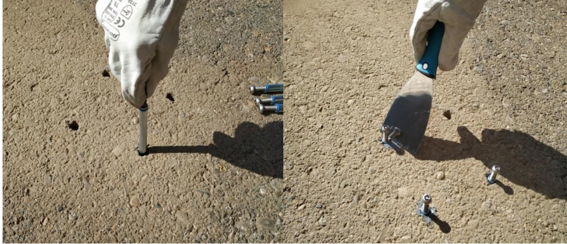
Εικόνα 80: Τοποθέτηση αγκίστρων (βήμα 6)
