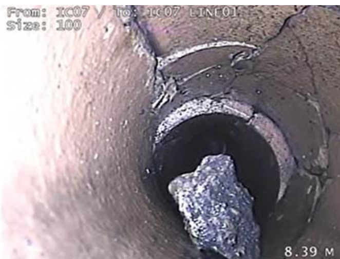
Εικόνα 1.1 Επιθεώρηση του εσωτερικού ενός αγωγού με τη χρήση κάμερας.
