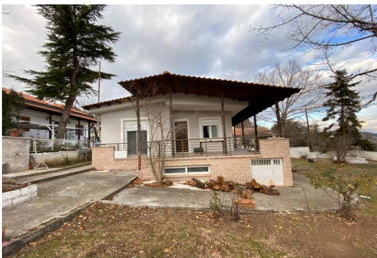
Εικόνα 3.30: Πρόσωση κτιρίου (πηγή: προσωπικό αρχείο)
