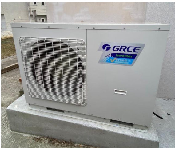
Εικόνα 3.21: Αντλία θερμότητας (πηγή: προσωπικό αρχείο)
