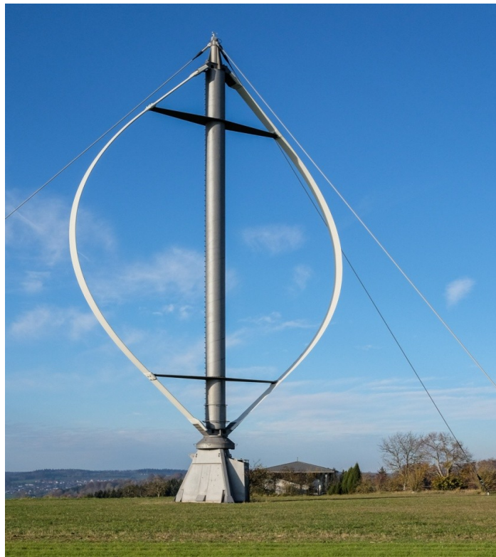
Σχήμα 1.5 Ανεμογεννήτρια Darrieus [5]
