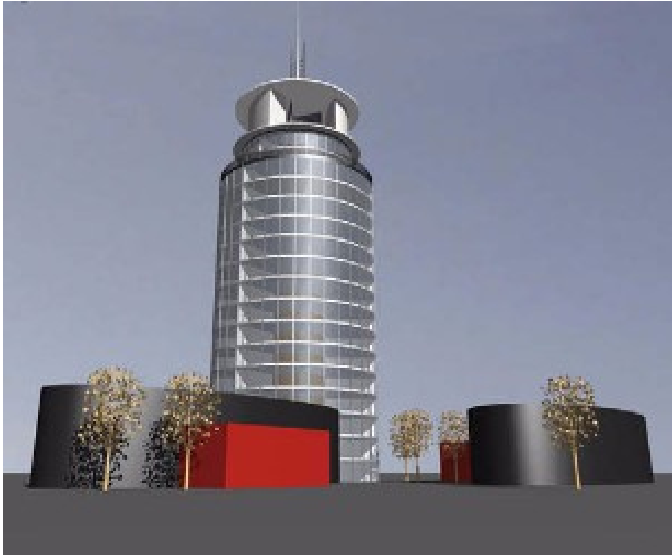
Σχήμα 1.8 Ανεμογεννήτρια καθέτου άξονα προσαρμοσμένη στην κορυφή κτηρίου [14]
