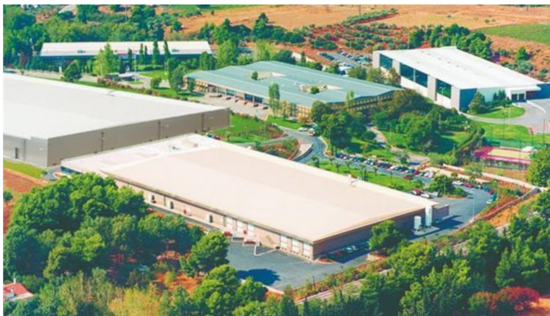
Εικόνα 1: Εξωτερικός Χώρος Βιομηχανίας Bic Violex
