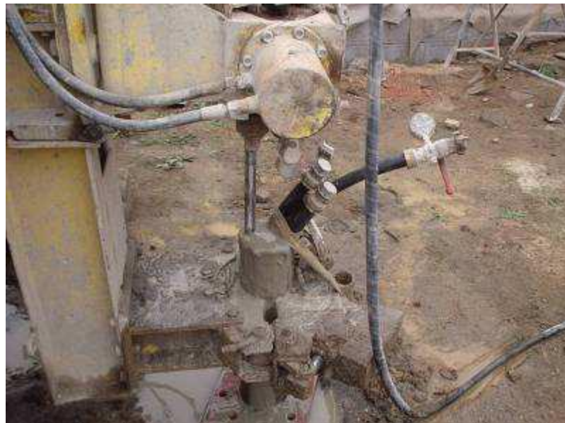
Σχήμα 5.23 : Έλεγχος Πίεσης (Πηγή: REHAU)
