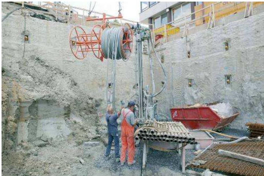
Σχήμα 5.20 : Τοποθέτηση Γεωαναλλάκτη (Πηγή: REHAU)
