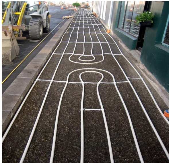
Σχήμα 1.4 Αντιπαγετική προστασία πεζοδρομίου (Πηγή: http://www.thinkgeoenergy.com )
