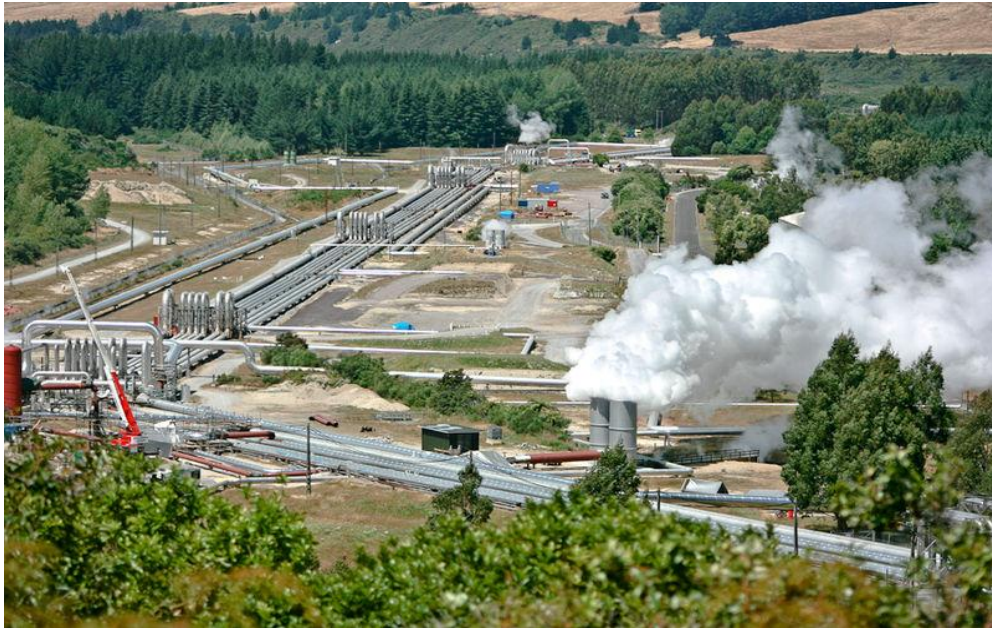
Σχήμα 1.6 Γεωθερμικό εργοστάσιο παραγωγής ηλεκτρικής ενέργειας στη Ν. Ζηλανδία (Πηγή: https://commons.wikimedia.org )
