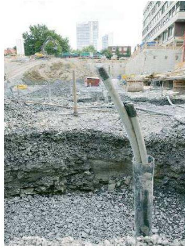
Σχήμα 5.22 : Γέμισμα (Πηγή: REHAU)
