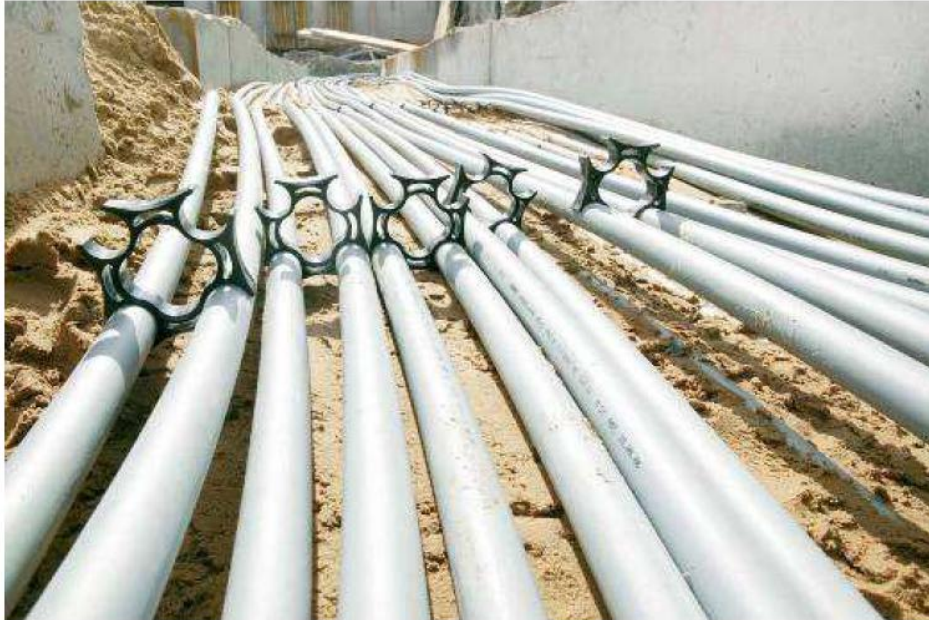
Σχήμα 5.19 : Τοποθέτηση αποστατών (Πηγή: REHAU)
