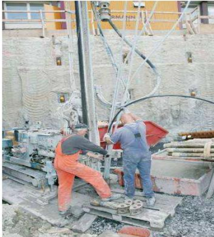
Σχήμα 5.21: Τοποθέτηση Γεωεναλλάκτη (Πηγή: REHAU)
