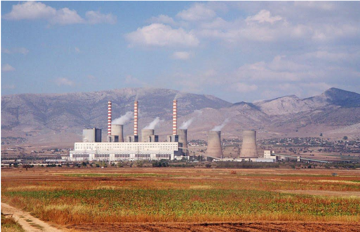
Εικόνα 1: Μονάδα παραγωγής θερμότητας 1
