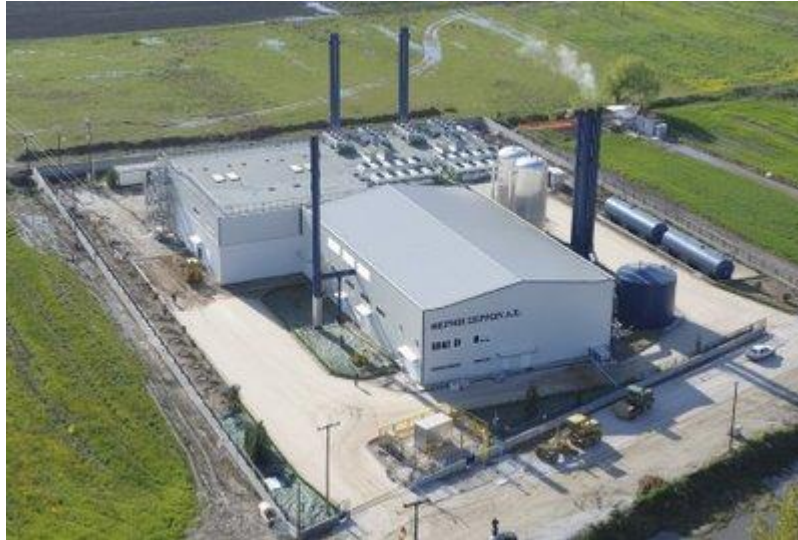
Εικόνα 9: Η μονάδα συμπαραγωγής - Τηλεθέρμανση Σερρών 14
