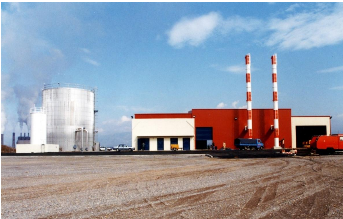
Εικόνα 8: Αντλιοστάσιο – Τηλεθέρμανση Μεγαλόπολης 13
