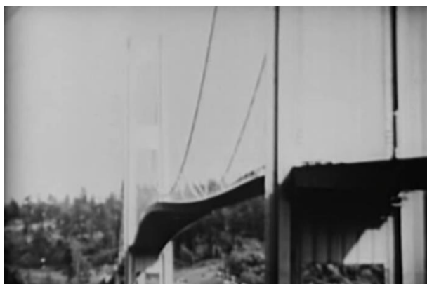
Σχήμα 3: Πτερυγισμός (flutter), Γέφυρα Tacoma (αριστερά), Ανεμόπτερο (δεξιά). (Wikipedia)
