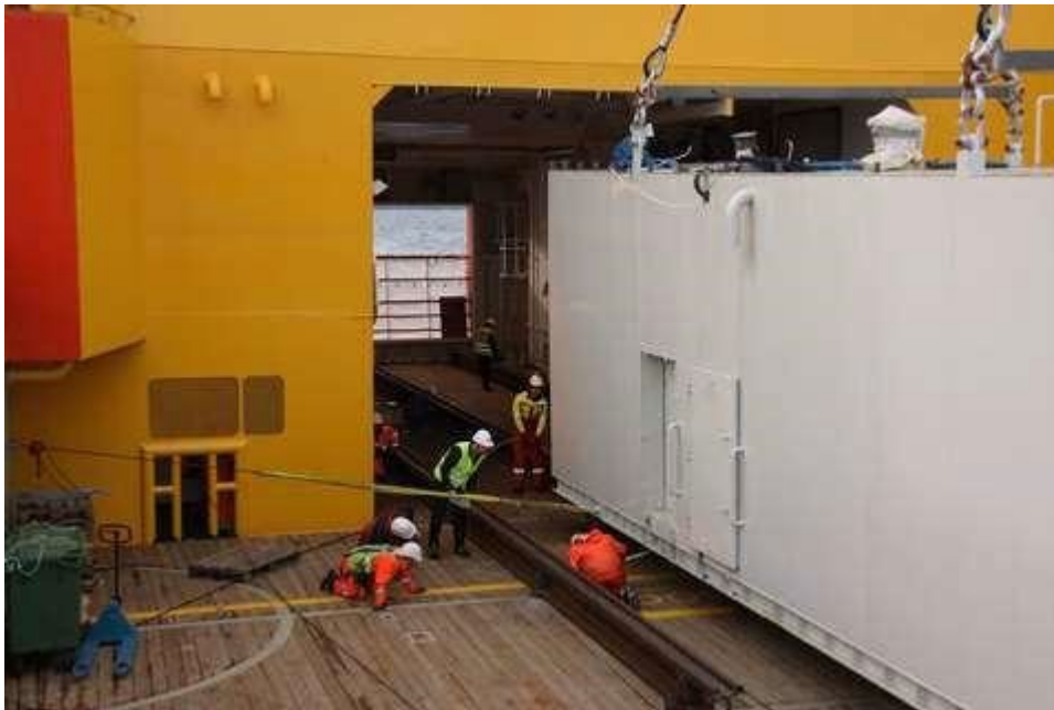
Εικόνα 29: Τοποθέτηση της κυψέλης καυσίμου στο σκάφος (Πηγή: https://www.ship-technology.com/projects/viking-lady )
