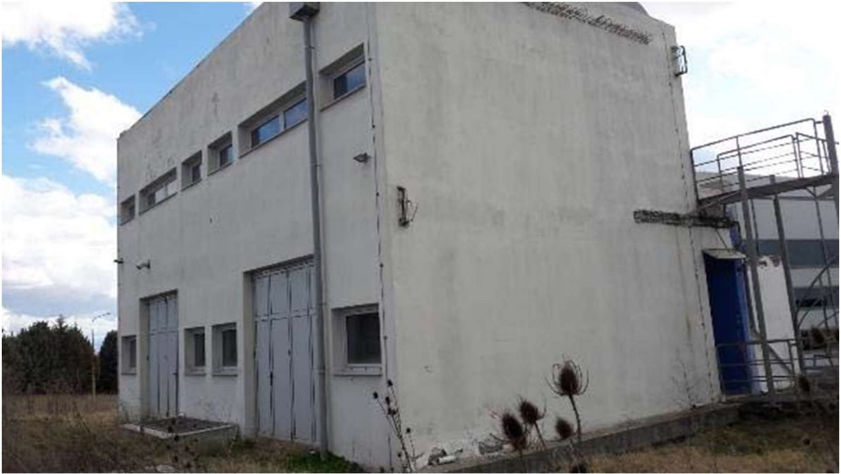
Εικόνα 15: Φωτογραφία του αρχικού κτιρίου ΕΚΕΤΑ από την Βορειοανατολική όψη
