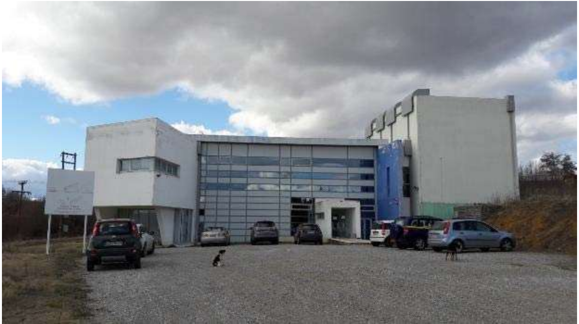
Εικόνα 13: Φωτογραφία του αρχικού κτιρίου ΕΚΕΤΑ από την Νοτιοανατολική όψη
