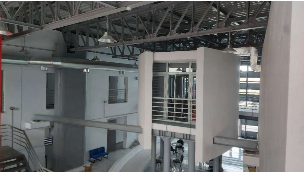
Εικόνα 23: Εσωτερικός χώρος 1 ου ορόφου κτιρίου ΕΚΕΤΑ Πτολεμαΐδα (δεν υπάρχει δάπεδο στο μεγαλύτερο τμήμα)
