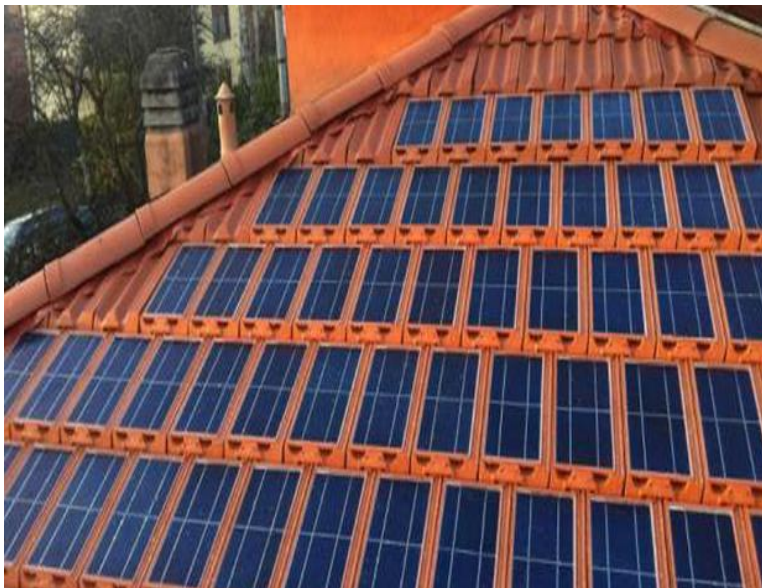
Εικόνα 5 Κεραμίδια – Φωτοβολταϊκά
