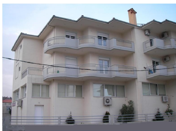
δ. Νότια όψη κτιρίου
