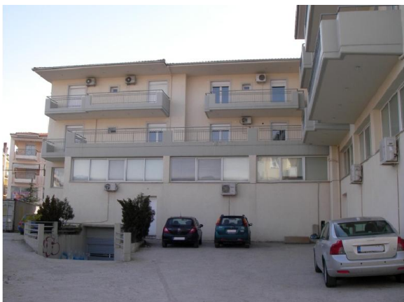
γ. Δυτική όψη κτιρίου
