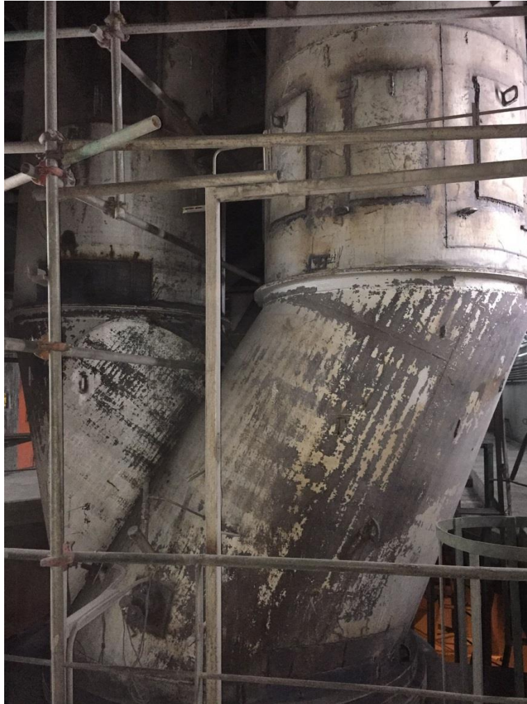
Σχήμα 3.14: Αγωγοί μίγματος αέρα – λιγνίτη μετά τον διαχωρισμό τους [6]
