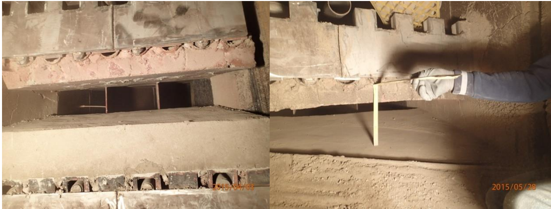
Σχήμα 3.29: Μειωμένη διατομή παροχής δευτερογενούς αέρα [6]
