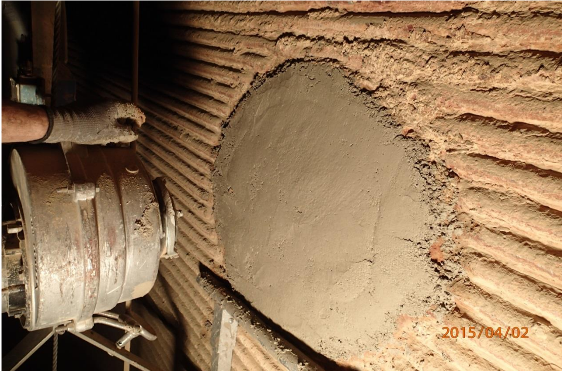
Σχήμα 3.18: Οπή OFA 1 μετά τη σφράγιση [6]
