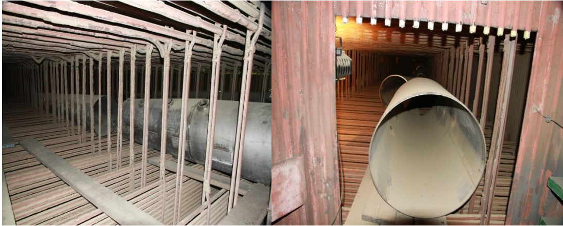
Σχήμα 3.23: Οι μεταλλικές λόγχες κατά την τοποθέτησή τους στον λέβητα [6]
