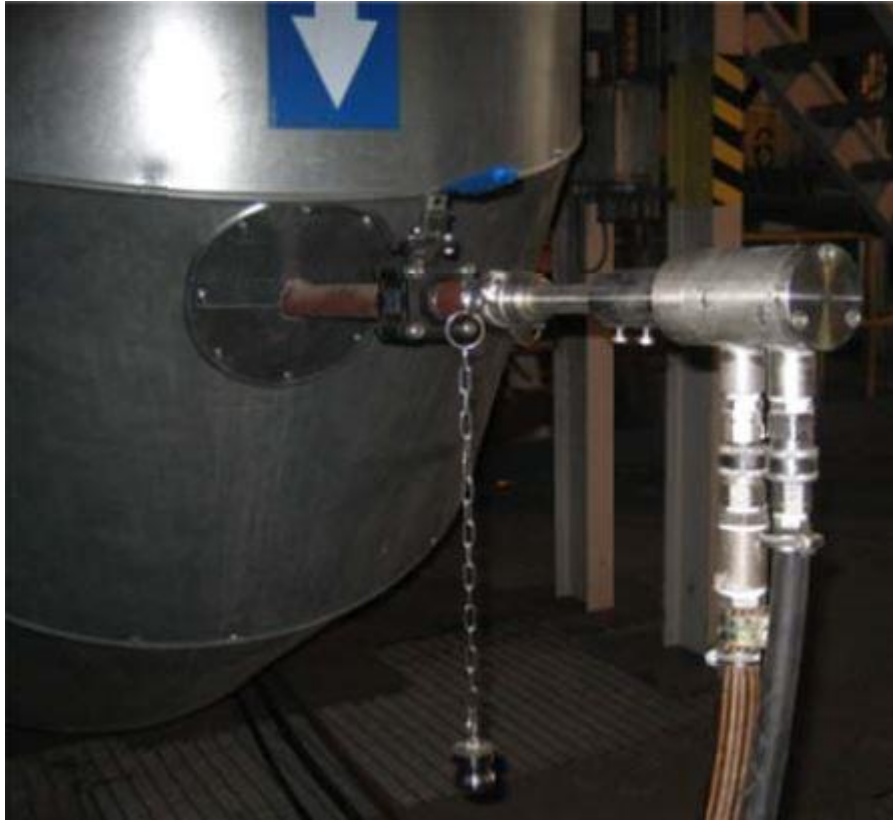
Σχήμα 2.7: Ψεκασμός ουρίας στον αγωγό αέρα [10]
