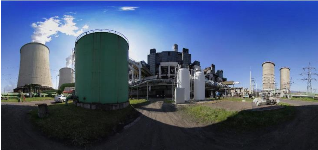
Σχήμα 2.1: Ο θερμοηλεκτρικός σταθμός Mátrai Erőmű [9]
