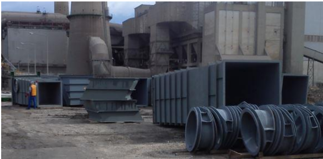
Σχήμα 3.24: Οι μεταλλικοί αγωγοί του OFA 2 πριν την τοποθέτησή τους [6]
