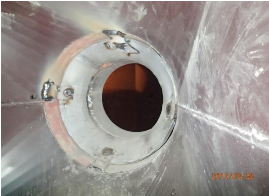
Σχήμα 3.19: Οπή OFA 1 μετά την μείωση της διατομής [6]
