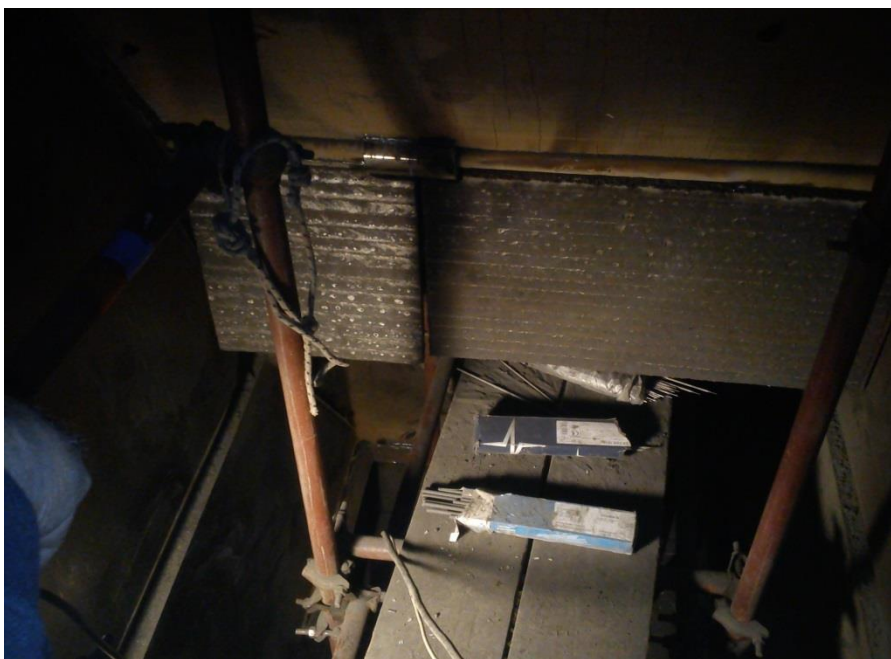
Σχήμα 3.12: Έλασμα διαχωρισμού σωματιδίων λιγνίτη (damper) [6]
