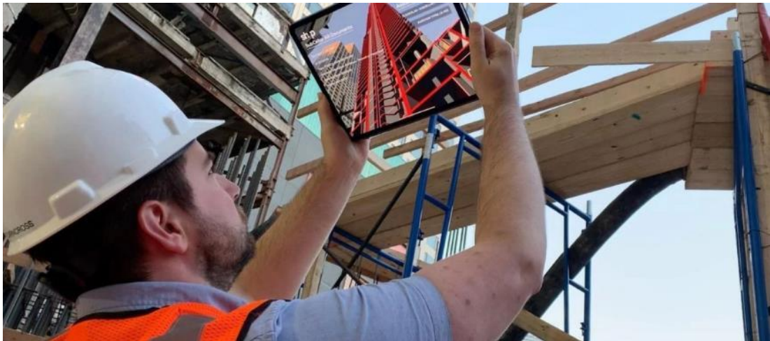
Εικόνα 34. AR in construction
